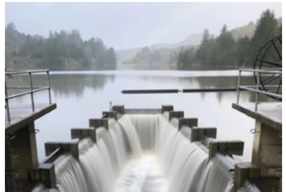
Desagüe del Embalse de Pilarcitos
