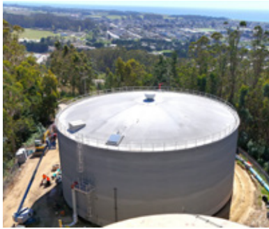
Nuevo tanque de hormigón pretensado de 2.1 millones de galones de Carter Hill
